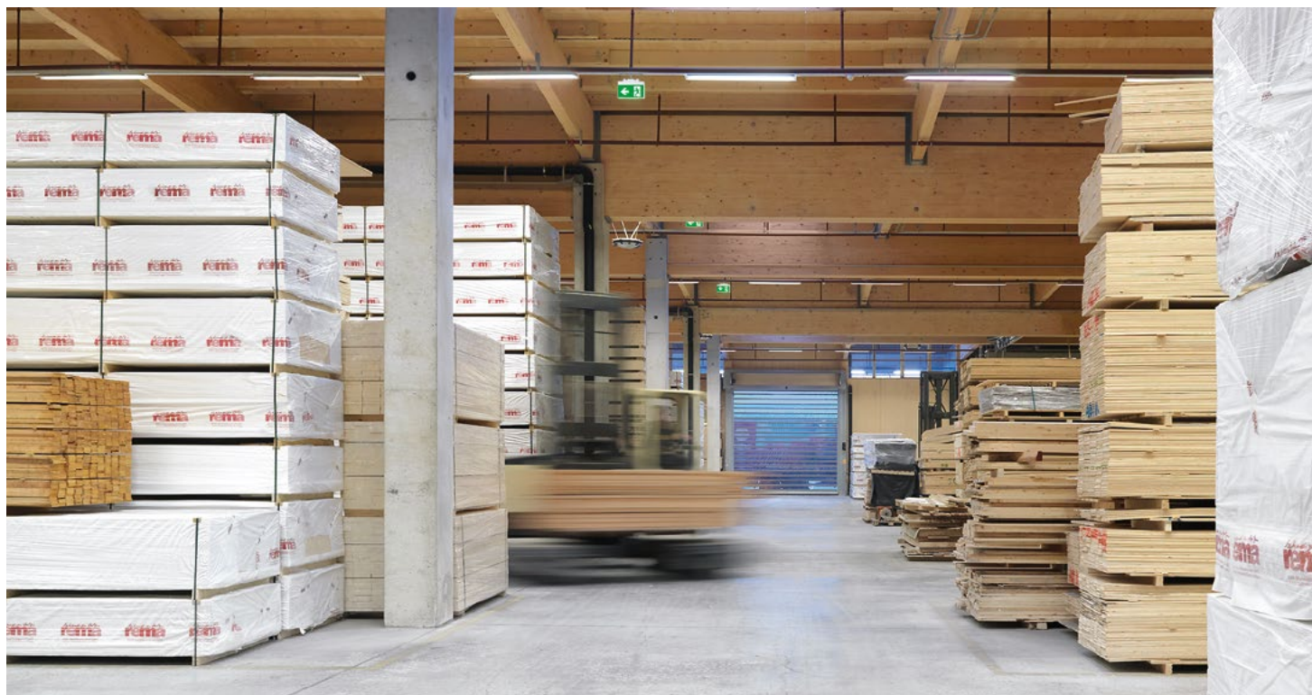
Industria del legno Rema, Eben im Pongau | AT Progetto e installazioni elettrotecniche: Elektrotechnik Kontriner, Bischofshofen | AT Soluzione illuminotecnica: impianto di emergenza ONLITE local controller SB 128, apparecchi segnaletici ONLITE ECOSIGN, Zumtobel apparecchi
