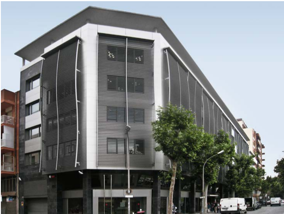
Bilder des Gebäudes. Oben das Gebäude im ursprünglichen Zustand. Unten das Gebäude nach der Renovierung.
