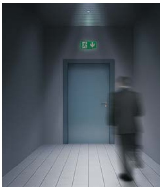
Verlichting van het pictogram met een luminantie van 2 cd/m 2
