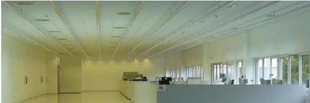
Productiehal kort na de lichtinstallatie in 2005. De arbeidshal is daarbij nog niet volledig ingericht en de verschillende delen van de hal zijn voor de demonstratie bewust met twee verschillende lichtsituaties verlicht om de verschillende kleurtemperaturen te tonen.
