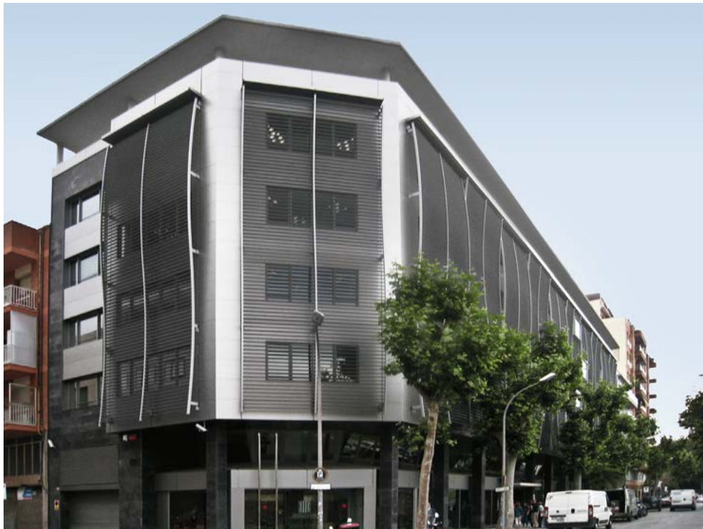
Foto's van het gebouw. Bovenaan het gebouw in zijn oorspronkelijke staat. Onderaan het gebouw na de renovatie.
