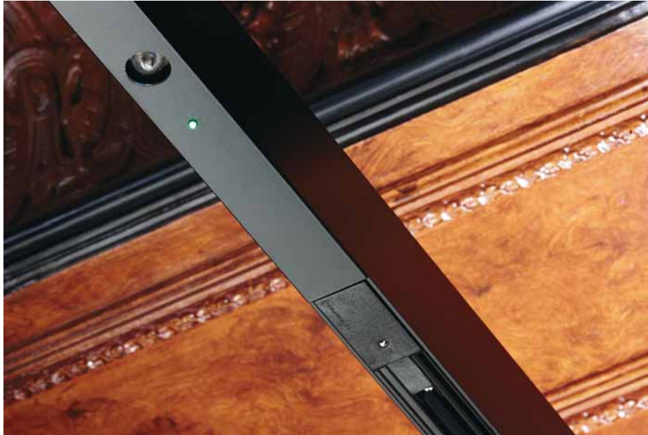
Museum M, Leuven / BE: projectgebonden uitvoering van RESCLITE in 3-faserail
