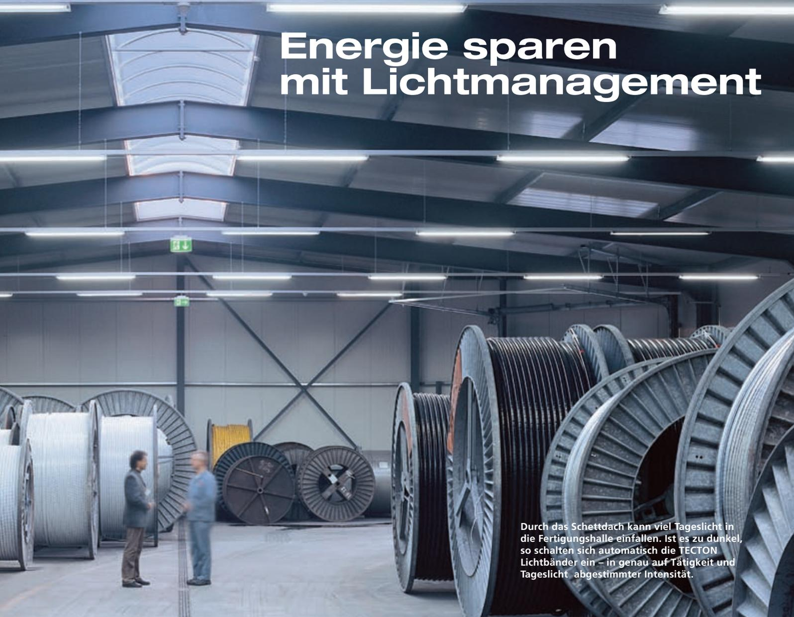
Durch das Schettdach kann viel Tageslicht in die Fertigungshalle einfallen. Ist es zu dunkel, so schalten sich automatisch die TECTON Lichtbänder ein – in genau auf Tätigkeit und Tageslicht abgestimmter Intensität.
