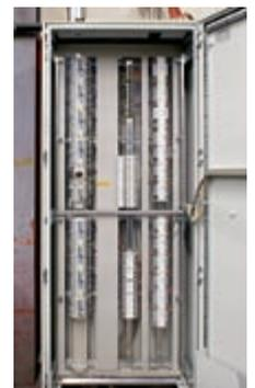
Je ein Elektrokasten für Lichtmanagement und Notlicht sind das Herzstück der Installation.
