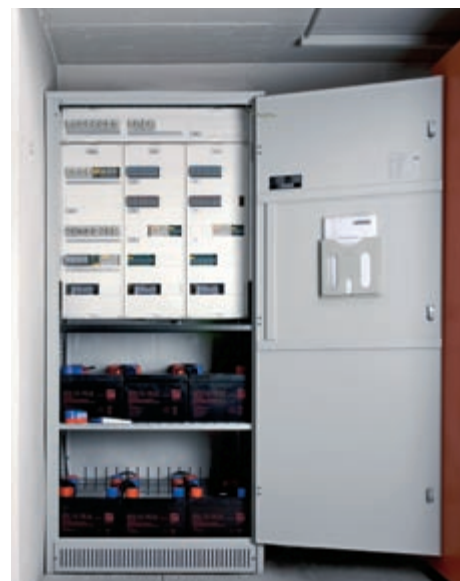
Viel Sicherheit auf wenig Raum: Die Zentralbatterieanlage ONLITE CPS überwacht aus dem Keller das Notlichtsystem.
