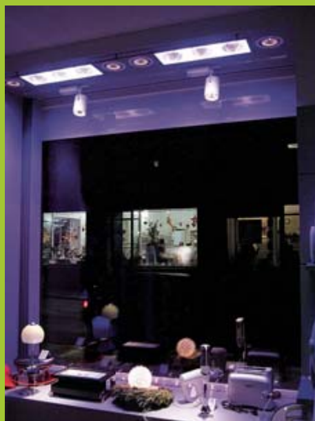
Elektro Hediger inszeniert seine Schaufenster nach dem Active Light-Konzept von Zumtobel Staff: Licht, das seine Farbe dynamisch verändert, erweckt Aufmerksamkeit. Die technische Umsetzung erfolgt mit dem Downlight PANOS, der Deckeneinbauleuchte 2LIGHT sowie dem neuen Strahler VIVO.
