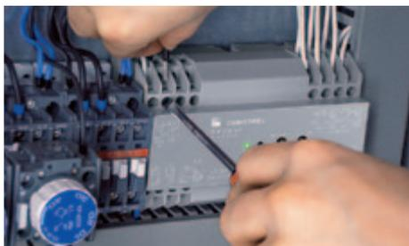
Pour la pose et la mise en service de DIMLITE, l'installateur n'a besoin que d'un simple tournevis – l'appareil de commande s'initialise de lui-même.
