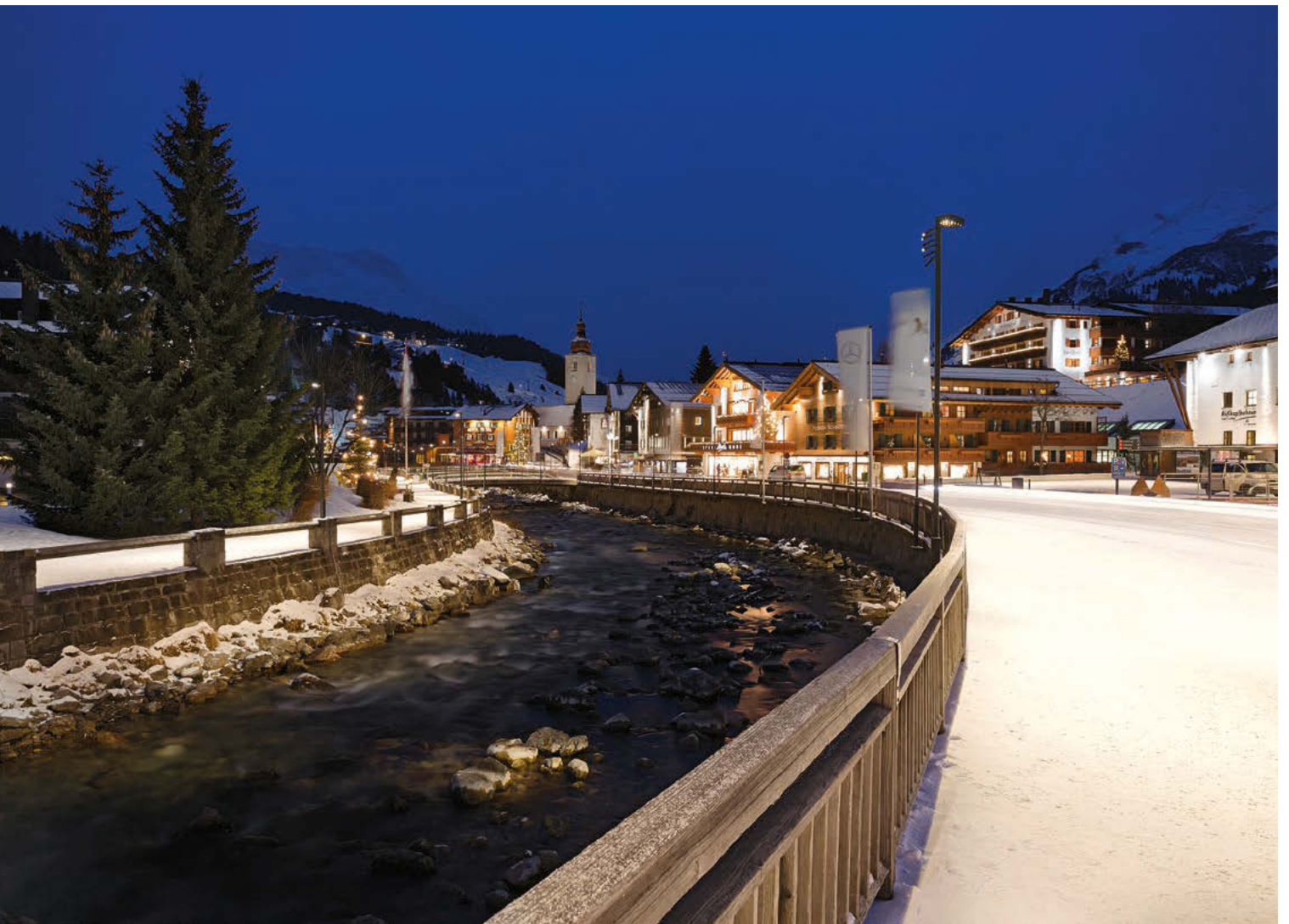
Gemeinde Lech am Arlberg, Lech am Arlberg | AT Bauherr: Gemeinde Lech am Arlberg, Lech am Arlberg | AT Lichtplanung: Dieter Bartenbach, Innsbruck | AT Lichtlösung: Mast- und Fassadenleuchte SUPERSYSTEM outdoor, zentrales Zumtobel Outdoor-Lichtmanagementsystem mit Web-Interface
