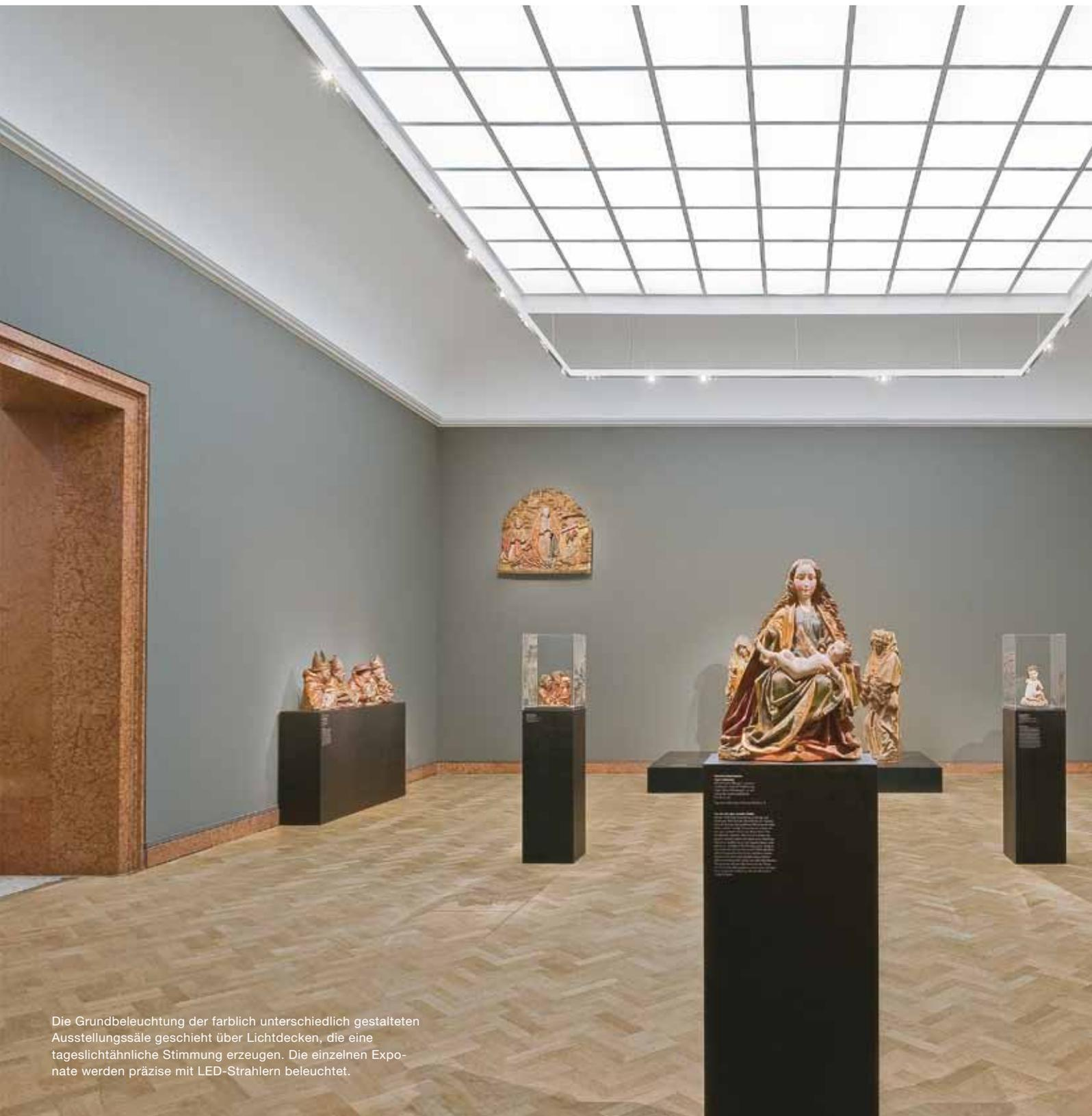
Die Grundbeleuchtung der farblich unterschiedlich gestalteten Ausstellungssäle geschieht über Lichtdecken, die eine tageslichtähnliche Stimmung erzeugen. Die einzelnen Exponate werden präzise mit LED-Strahlern beleuchtet.
