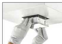
Insert luminaire
