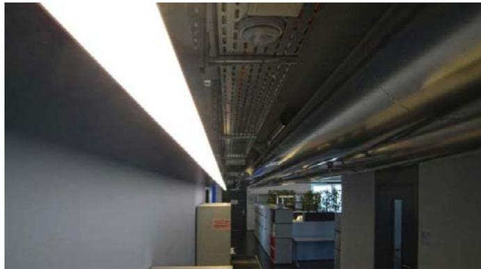
Nei quadri elettrici del settimo e dell'ottavo piano sono stati installati due contatori che registravano esclusivamente l'illuminazione dei rispettivi corridoi trasferendo i dati su schede di memoria tramite data logger. L'intervallo di misurazione impostato era di un minuto. Ciò significa che in ogni corridoio sono stati registrati 1440 valori di potenza al giorno, per un totale di 300.000 dati. Oltre alle registrazioni automatiche si sono prelevati dati di prova anche manualmente.
