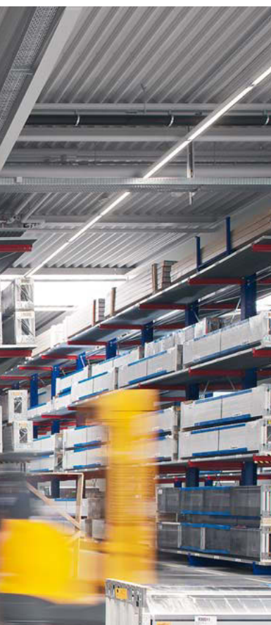
Selbst Lagerhallen mit 18 Meter Höhe beleuchtet das Lichtbandsystem TECTON gleichmäßig und in hoher Qualität.
