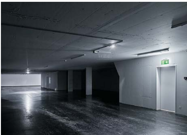
Die Fluchtwegbeleuchtung in der Tiefgarage übernehmen ECOSIGN Rettungszeichenleuchten und RESLITE Sicherheitsleuchten. Mit nur zwei LED-Leuchten wird das Parkdeck mit der im Notfall geforderten Helligkeit versorgt.
