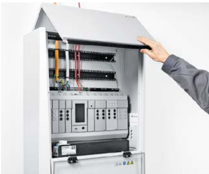
Die Versorgung der Notlichtanlage erfolgt über eine zentrale eBox und zwei Gruppenbatteriestationen.
