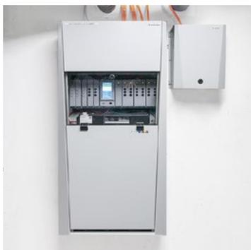
La surveillance et l'alimentation automatiques de l'éclairage de sécurité dans tout le centre jardin se font depuis l'armoire d'énergie centrale eBox.
