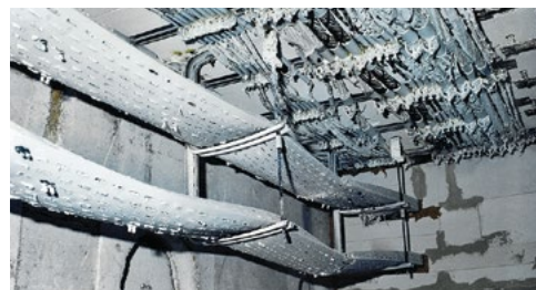
Construction après l'essai Source photo: photos de Dätwyler Cables GmbH
