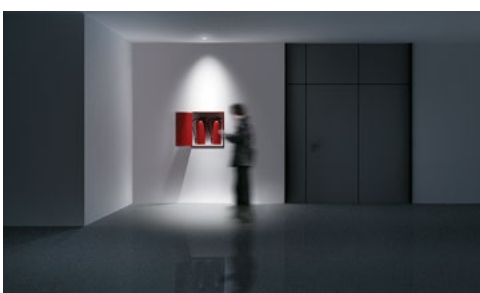
> 5lx dans le plan vertical si l'installation se trouve en dehors de la voie d'évacuation
