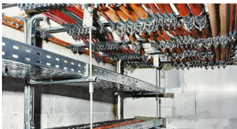
Construction avant l'essai
