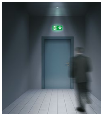
Éclairage du pictogramme avec une luminance de 200 cd/m 2
