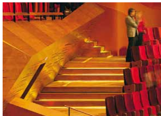
I Wallwasher inseriti nel pavimento provvedono a un'illuminazione sicura e suggestiva delle scale nella sala principale (in alto).
