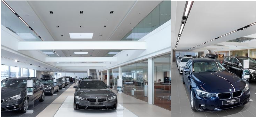
Bild 3 und 4: Für die Beleuchtung des Showrooms entwickelte Zumtobel eine Sonderlösung basierend auf dem modularen LED-Beleuchtungssystem INTRO.
