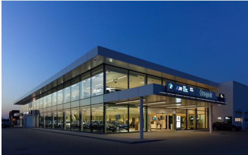
Bild 1: Der Neubau von BMW Gregoir im belgischen Puurs erstreckt sich auf zwei Stockwerken und strahlt nun weithin sichtbar.
