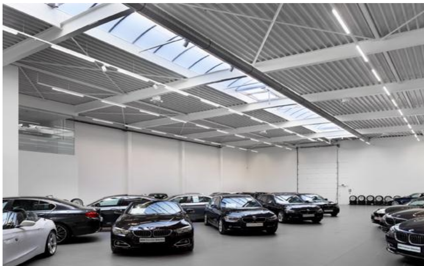
Bild 5: In den Verkaufsräumen für Gebrauchtwagen setzte Zumtobel auf eine reduzierte Beleuchtung in Verbindung mit Tageslicht.
