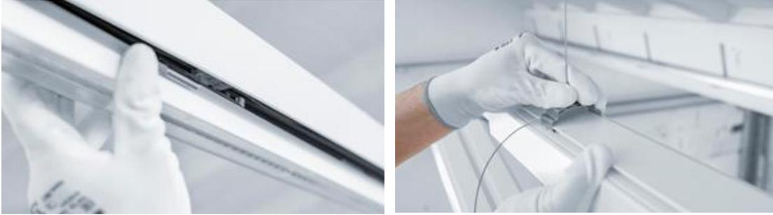
**Illustration 3a + b :** Grâce à un outil de montage innovant et à la technologie CLIX, TRINOS s'installe facilement et rapidement en toute sécurité jusqu'à 50 mètres. Rails, chemins lumineux et modules d'éclairage sont fabriqués selon des dimensions métriques alors que le profil d'étanchéité, le câblage et le couvercle sont livrés sur des rouleaux.
