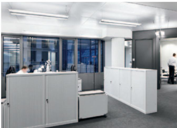
La variante suspendue du « luminaire-épée » éclaire, entre autres, les postes de travail au rez-de-chaussée (gauche). Le profilé support des lampes équipées sur les deux faces est encadré de prismes de lumière en forme d'épées (bas).
