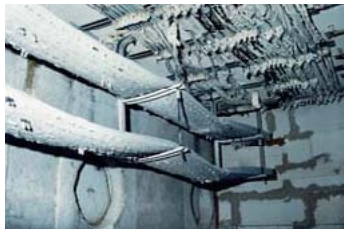
Versuchsaufbau nach der Prüfung
