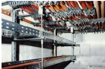
Versuchsaufbau vor der Prüfung
