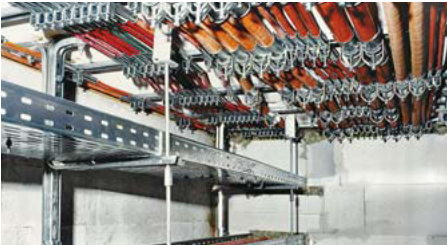
Construction avant l'essai
