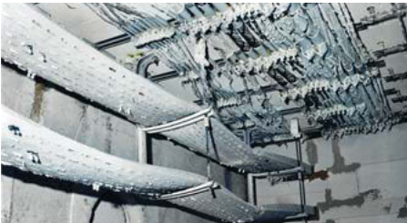
Construction après l'essai
