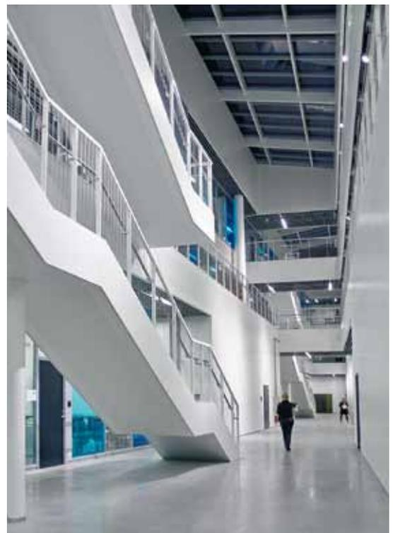
B2 I Per la parte più grande dell'edificio i progettisti hanno studiato un sistema a soffitto costituito da lamelle d'alluminio perforate nel quale anche l'illuminazione dovrebbe essere integrata. Per poter soddisfare al meglio le molteplici esigenze riguardanti le lampade, l'appaltatore ha bandito un concorso: la scelta è caduta su Zumtobel.
