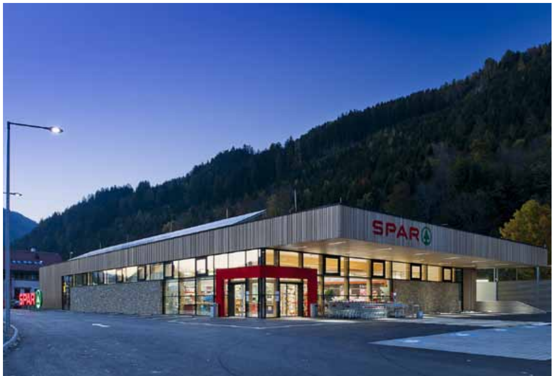
B3 | Même le soir, la lumière accueillante des luminaires à LED Hedera attire l'attention sur le supermarché de Murau.
