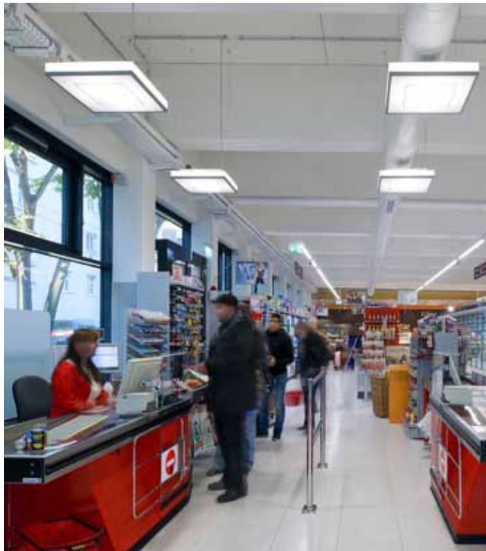
B6 | Les zones des caisses sont parfaitement éclairées par des luminaires suspendus à LED Careena.
