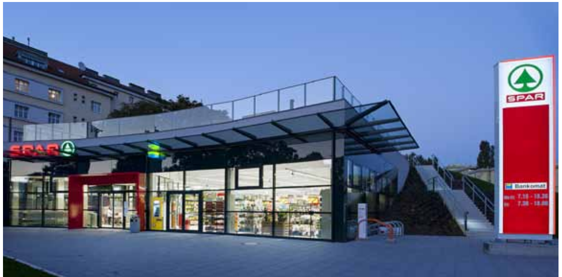
B5 | Même de l'extérieur, le magasin SPAR à Vienne se montre écologique : le toit praticable contraste de manière spectaculaire avec les bâtiments de supermarché classiques.
