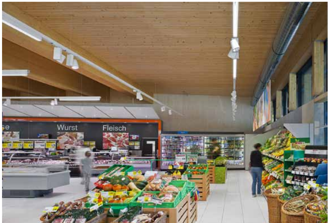
B2 | Het lichtlijnsysteem Tecton LED en de LED-spots SL 1000 garanderen een hoge lichtkwaliteit en een aantrekkelijke productpresentatie bij een tegelijk gering energieverbruik.
