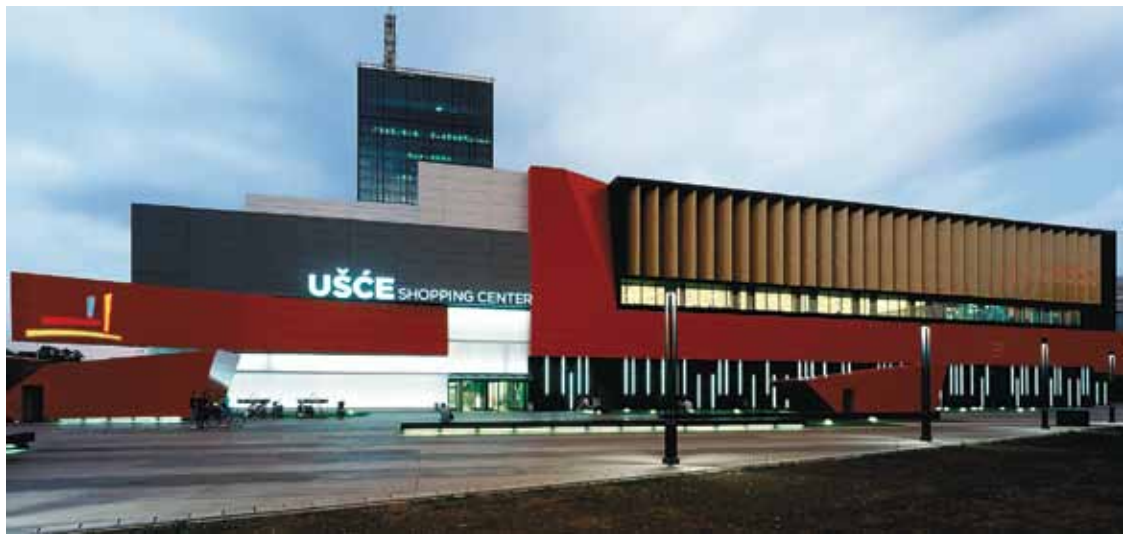
B2 | La façade rouge lumineuse du nouveau centre commercial attire les regards et éveille la curiosité.
