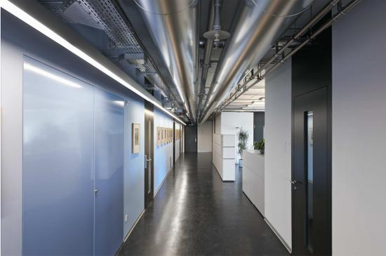
Photo 2: Un des deux couloirs n'a pas été modifié pour le projet pilote, l'autre couloir était équipé des luminaires innovants Slotlight à LED de Zumtobel.
