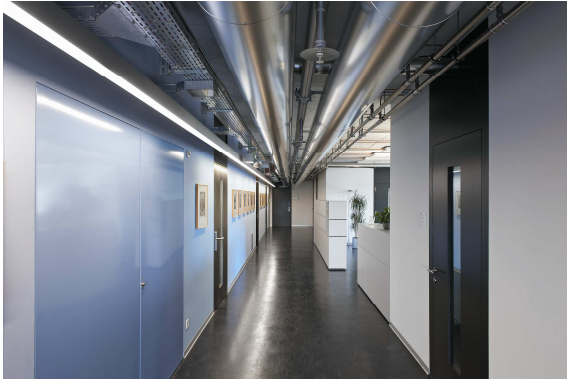
Foto 2: Een van de beide gangen bleef voor het pilootproject ongewijzigd; oor de andere gang werd overgeschakeld naar de innovatieve Slotlight LED armaturen van Zumtobel
