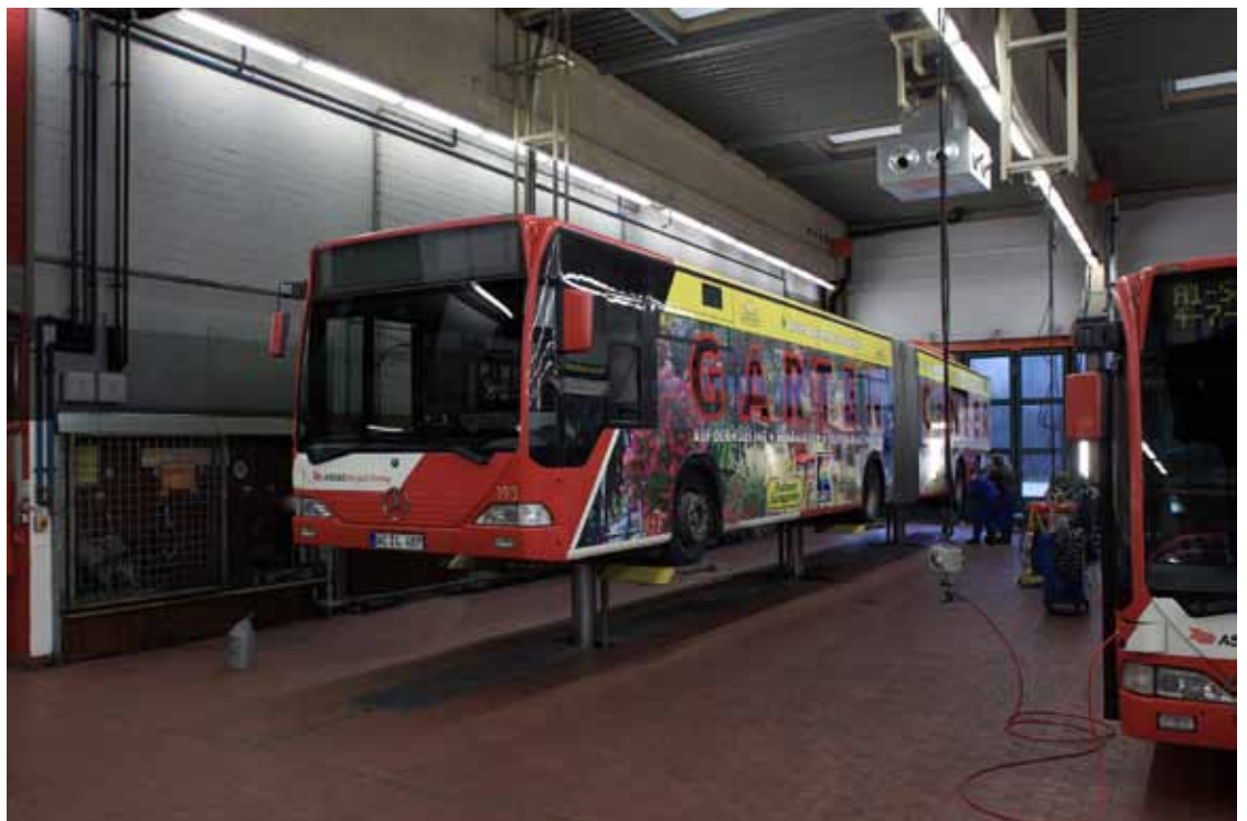
B2 | Les luminaires pour locaux humides Scuba utilisés ici sont commandés efficacement par le système de gestion de l'éclairage Luxmate Professional.
