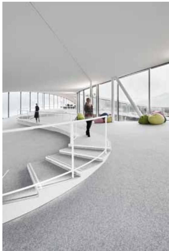
B5 | Les charges de la construction de toiture sont réparties sur quelques fines colonnes seulement et sur les poteaux de façade des patios. Dans l'ensemble, les éléments encastrés ont été évités afin de conserver l'impression de fluidité de l'espace.
