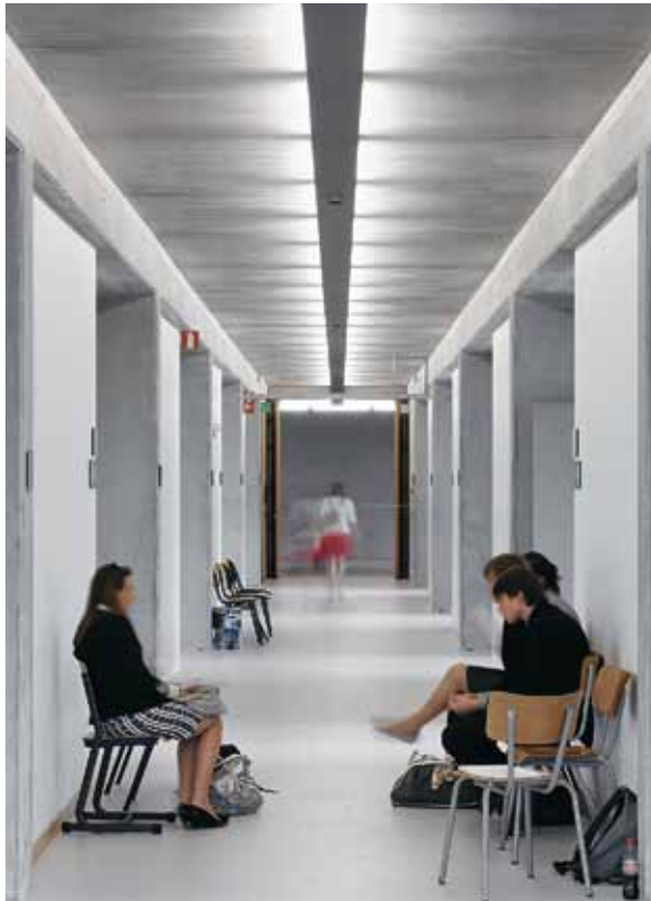
B4 | Das Miro's Spiegel-Werfer-System wirkt fast wie ein Teil der Gebäudekonstruktion. Das über die Spiegel entstehende indirekte und warme Licht bildet einen spannenden Kontrast zu der kühlen Beton/Glas-Architektur.
