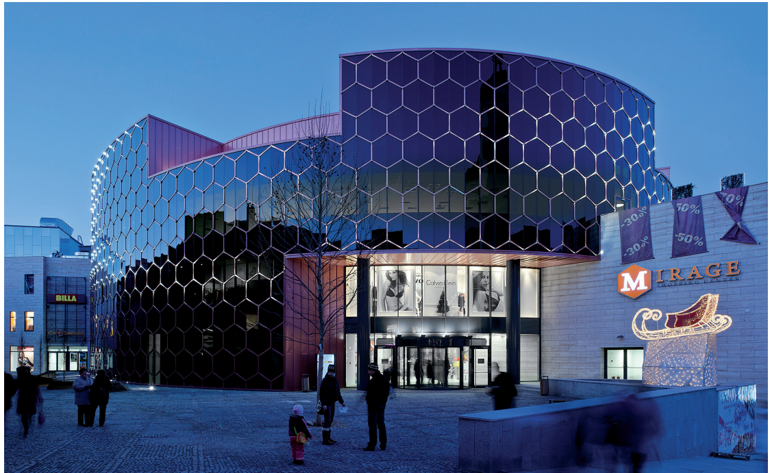
B2 | Am Tag sind sie kaum sichtbar, bei Nacht zaubern sie Licht auf die Fassade. In einer Sonderlösung installierte Zumtobel 2000 LED-Spots in die Metall-Glasfassade.
