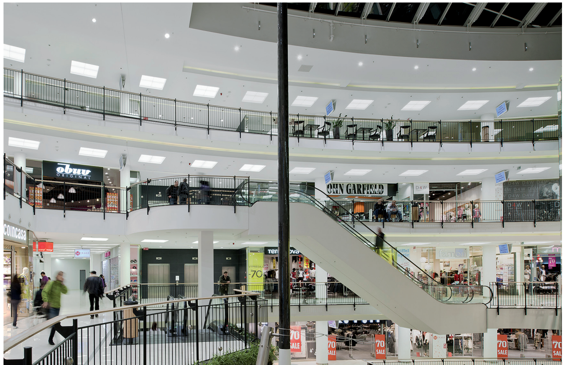
B3 | Das an den Decken der Gänge eingesetzte Lichtsystem Cielos sorgt für eine tageslichtähnliche Stimmung.
