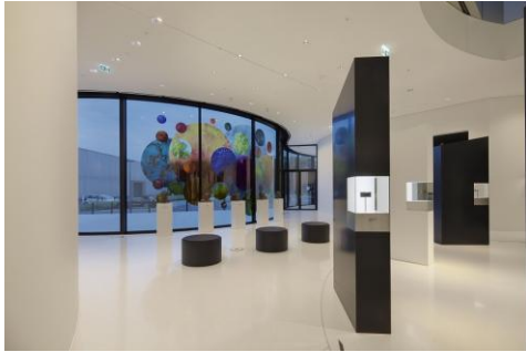
Foto 4: Terwijl Zumtobel de algemene verlichting met PANOS infinity downlights met een kleurtemperatuur van 3000 K realiseerde, werden de wallwashers door de inval van daglicht in een kleurtemperatuur van 4000 K ingezet.
