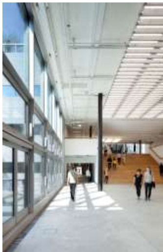
Foto 1: Zumtobel ha fornito l'impianto d'illuminazione formato da 5.500 apparecchi TECTON.
