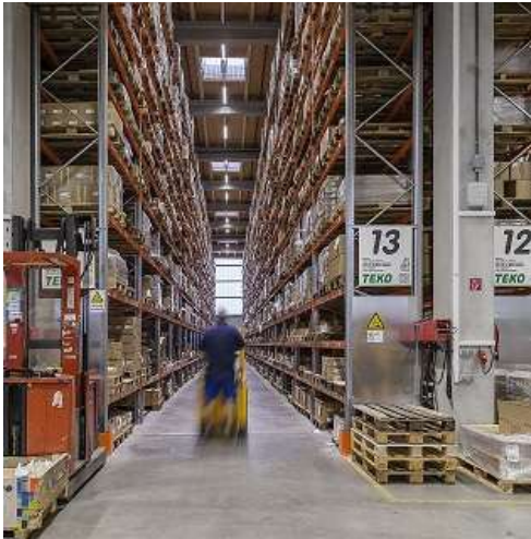
Foto 4: Il consumo annuo di corrente è crollato da 1,2 milioni a meno di 465.000 Kilowattora. In altre parole le emissioni di CO2 dovute all'illuminazione si sono ridotte di quasi 139 tonnellate all'anno, pari a solo al 38,6 percento della quantità precedente.
