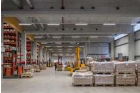
Foto 3: Scegliendo un nuovo impianto di file continue TECTON LED di Zumtobel, la nota azienda internazionale di trasporto e logistica è riuscita a ridurre di quasi due terzi le emissioni di CO2 causate dall'illuminazione nella sua sede di Pöchlarn.
