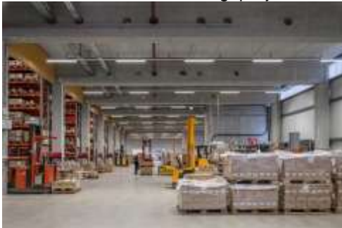
Foto 3: Met de lichtlijnoplossing TECTON LED van Zumtobel is de internationale transport- en logistieke onderneming erin geslaagd om in de overslaghal aan de vestiging in Pöchlarn de CO 2 -uitstoot vanuit de verlichting met bijna twee derde te verlagen.
