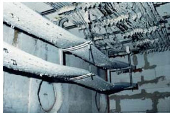
Versuchsaufbau nach der Prüfung
