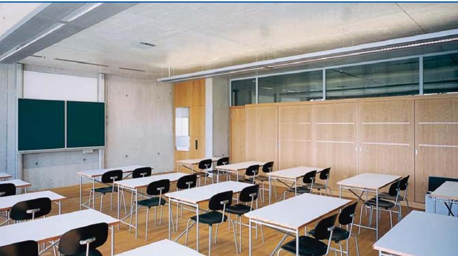
Le regroupement classique d'une salle de classe : le groupe de luminaires 1 est le lèche-mur dirigé vers le tableau. Le groupe de luminaires 2 rassemble les luminaires à distribution directe-indirecte pour l'éclairage général. Tous les luminaires sont graduables DALI, trois ambiances spécifiques à l'enseignement sont définies sur l'élément de commande CIRCLE.
