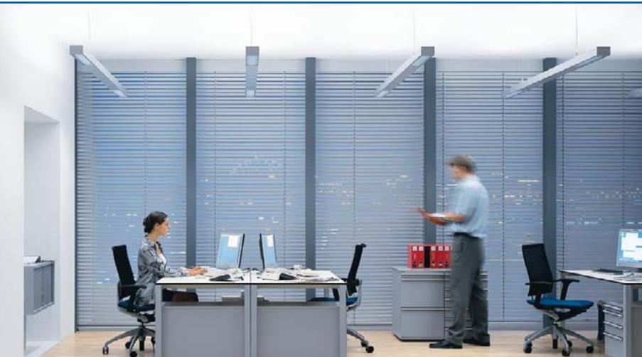
La répartition des groupes de luminaires s'effectue en fonction de la distribution lumineuse. Même lorsque les composantes directe et indirecte sont fournies par un même luminaire, comme c'est le cas avec le FREELINE, celles-ci peuvent néanmoins être sélectionnées et commandées séparément sur l'élément de commande CIRCLE. Les trois ambiances lumineuses les plus souvent utilisées sont programmées sur l'élément de commande CIRCLE.
