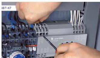
La única herramienta que el instalador necesita para el montaje del sistema de control de iluminación DIMLITE es un destornillador. Primero se instala el dispositivo base en el armario de distribución ...
