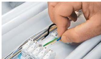
... luego se conectan las luminarias. El cableado puede ejecutarse con material NYM convencional. Las conexiones del control digital DALI o DSI disponen de protección contra la polarización invertida.
