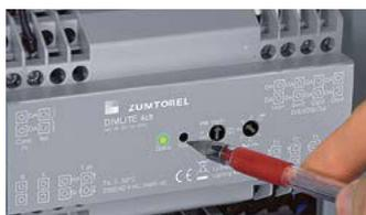
... l'unità base si inizializza automaticamente in pochi secondi. Il LED verde segnala che l'impianto è pronto per il funzionamento. Un'autentica soluzione «plug & play».
