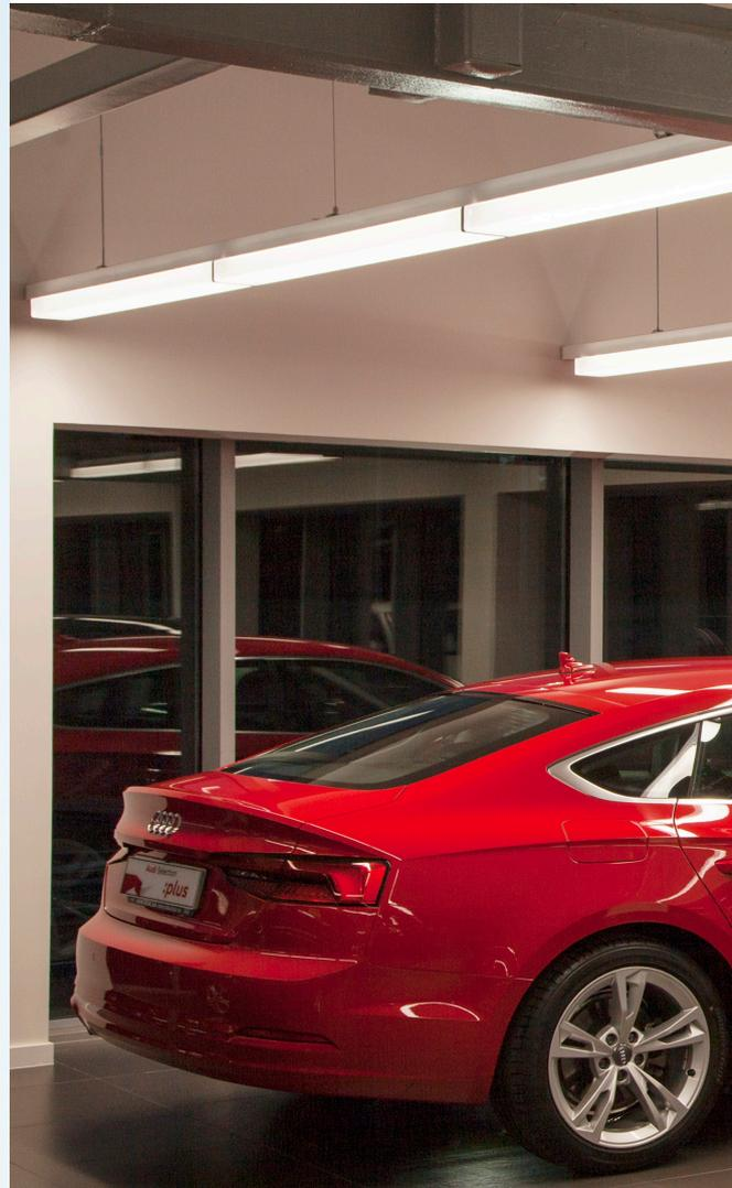
El mayor reto para Zumtobel Group supuso la correcta iluminación de vehículos a baja altura, ya que por la particularidad del techo abocardillado de su arquitectura, no era aplicable el uso de soluciones con sistemas empotrados o soluciones de carril.
