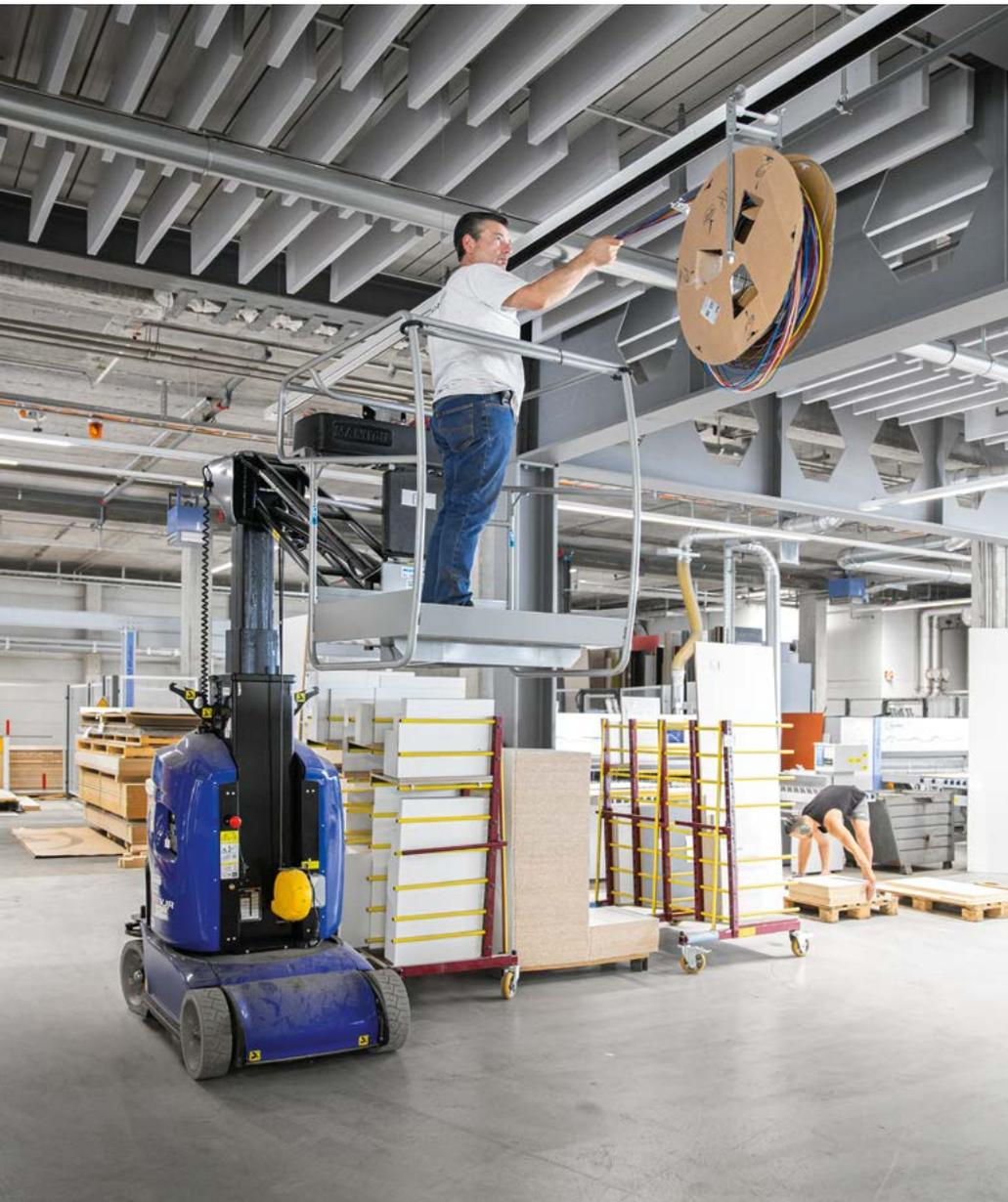
Lückenlose Sicherheit steht und fällt mit der Montage: Dank einem komfortablen Montagetool sind die bis zu 50 Meter langen Endloskomponenten in kurzer Zeit fehlerfrei montiert. Je länger die Lichtlinie, desto mehr Arbeitszeit lässt sich im Vergleich zu einer Lösung mit Einzelleuchten einsparen.
