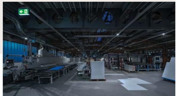
Mit der Sanierung wurde auch das Thema Sicherheitsbeleuchtung elegant gelöst: RESCLITE PRO Sicherheitsleuchten wurden direkt in die Schienen integriert, ECOSIGN Rettungszeichenleuchten mit flexiblen Schneidbuchsen in das Lichtbandsystem eingeklickt.
