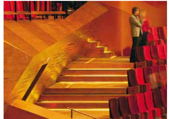
In de vloer aangebrachte wallwashers zorgen voor een veilige en sfeervolle verlichting van de trappen in de hoofdzaal (boven).
