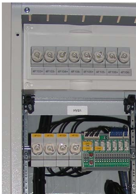
Abb. 10 Abgangssicherungen für externe Unterverteilungen in einem Kompaktschrank (hier in einer Sonderausführung)
