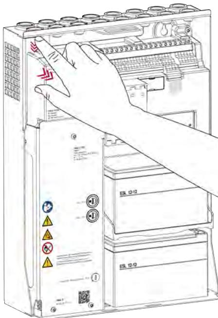
2. nBox ACM von der nBox entfernen.
