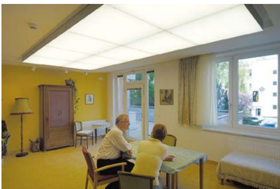
Abb. 4-4. Lichtdecke im Aufenthaltsbereich. Die Farbtemperatur und die Beleuchtungsstärke lassen sich wie beschrieben verändern.
